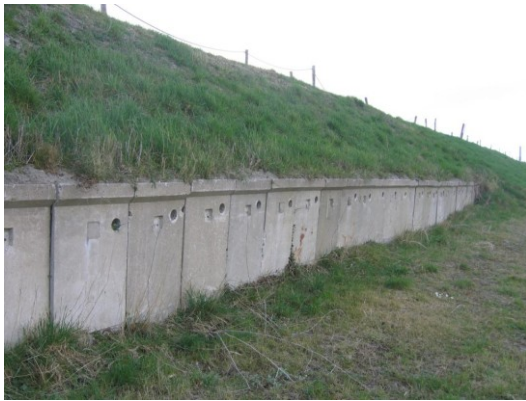
Keerwand met geboorde gaten bij Den Helder 30-3-2011. Foto: Jelle Harder
