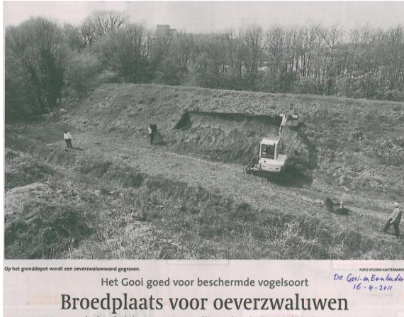
Aanleg wand op depot gemeente Huizen 15 april 2011
