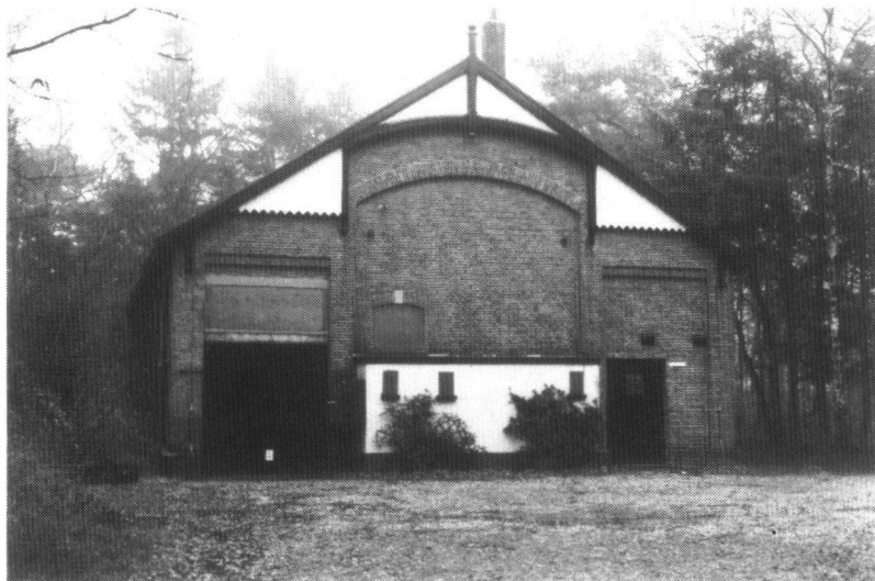
Het pompgebouw aan de zuidzijde, waar de hoofdingang van het "groene" clubhuis moet komen
