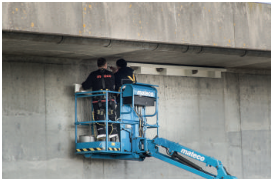
De panelen worden bevestigd.
