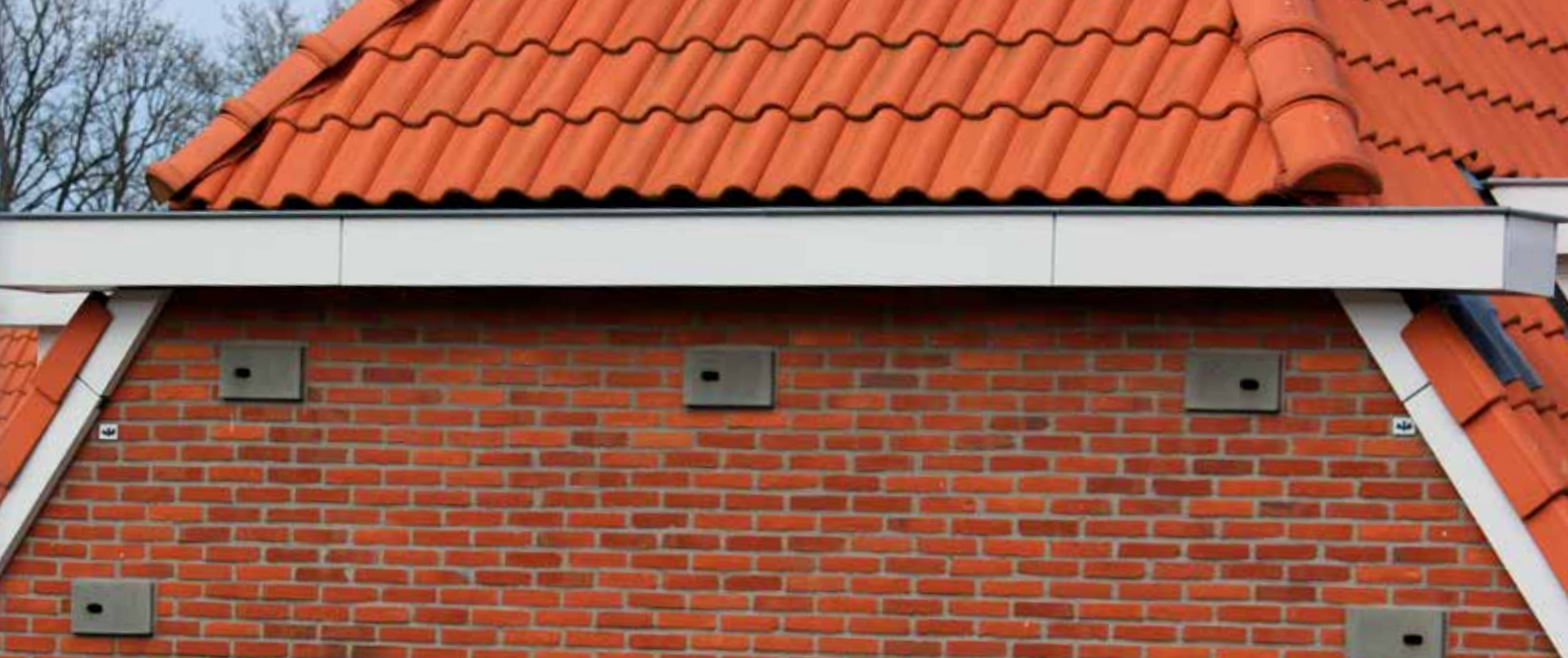
Ingemetselde nestkasten voor gierzwaluwen, die de mussen ook 'gebruiken'; Hilversum, april 2024 | Carel de Vink
