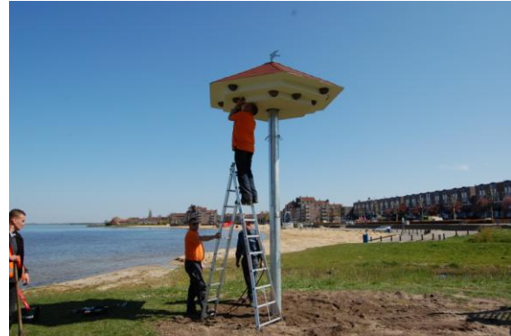
Bouw van de zwaluwtil bij Huizen
