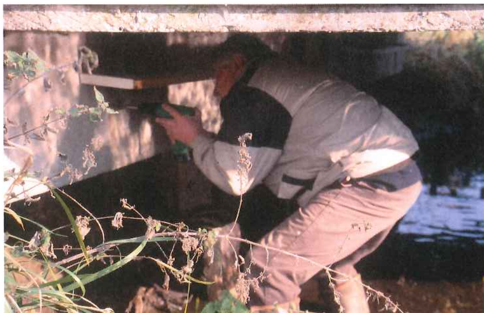
Montage van een nestplank onder een brug.
