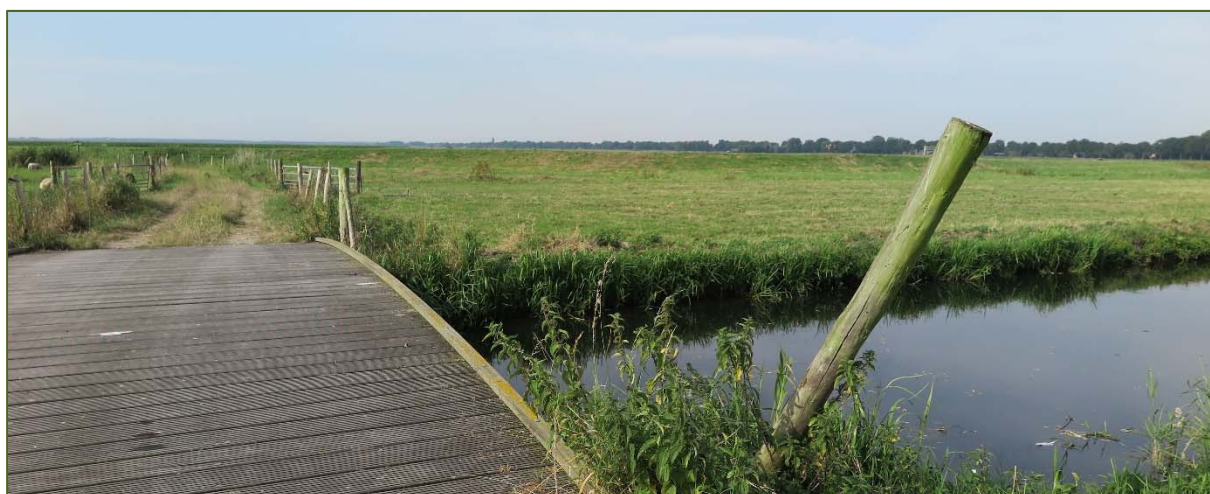
De Zomerdijk gezien vanuit telgebied Oostermeent.
